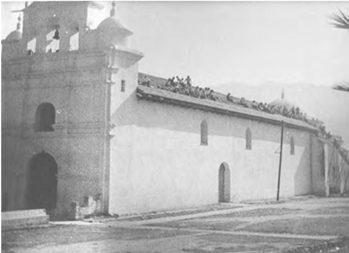
Figura 2. Iglesia de Jacaltenango, Huehuetenango. Se observan trabajadores reparando el techo. (Fotografía: Ramona Ramírez)
