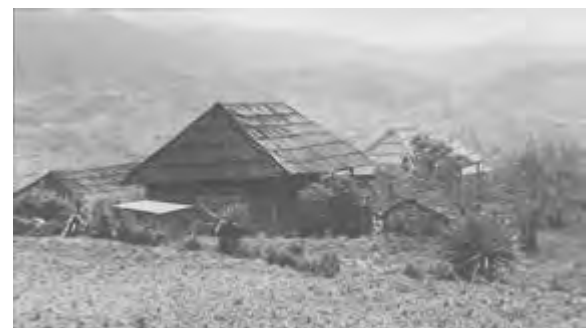
Figura 5. Casa con estructura compuesta y disposición en el terreno o solar, cabecera de San Mateo Ixtatán, 1998. (Fotografía: R. Piedrasanta).
