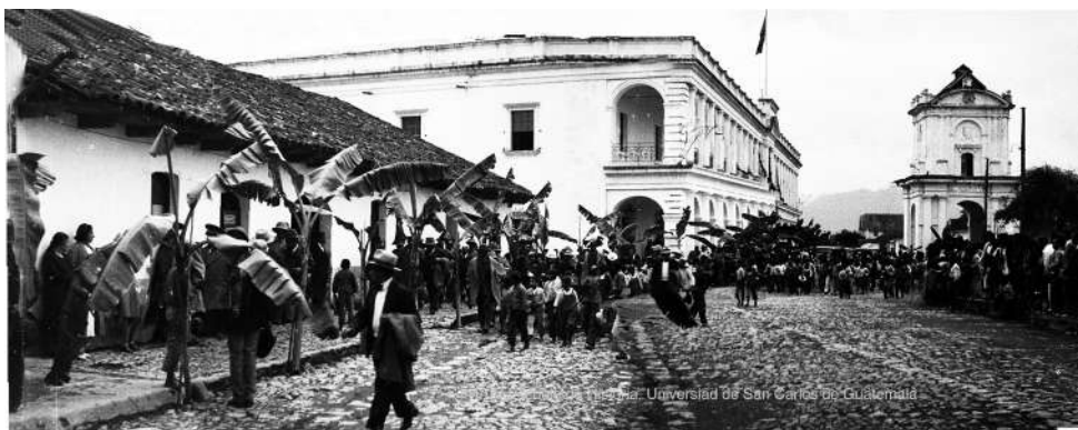
Figura 36 Panorámica de Gobernación y Torre en el parque de Cobán.
