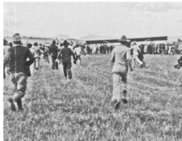
Figura 8. Pista de aterrizaje, aeródromo La Aurora.
