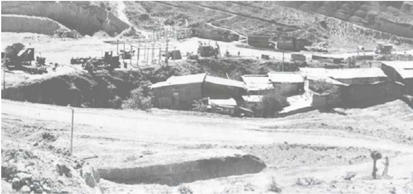
Figura 15. Panorámica del movimiento de tierras en el lugar en donde se construiría el Estadio Revolución, actualmente Estadio "Doroteo Guamuch Flores" Película de la Tipografía Nacional, 1948, Rollo 463. (Digitalización: E. Barillas).
