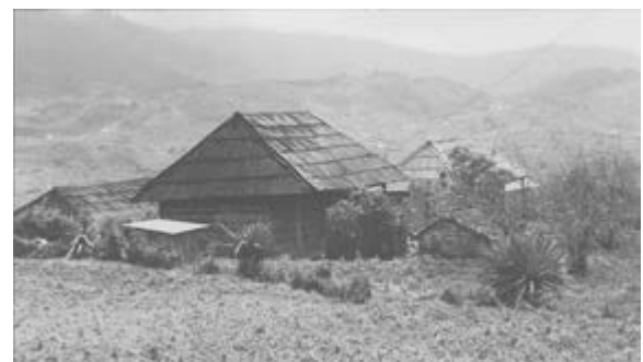
Figura 5. Casa con estructura compuesta y disposición en el terreno o solar, cabecera de San Mateo Ixtatán, 1998. (Fotografía: R. Piedrasanta).
