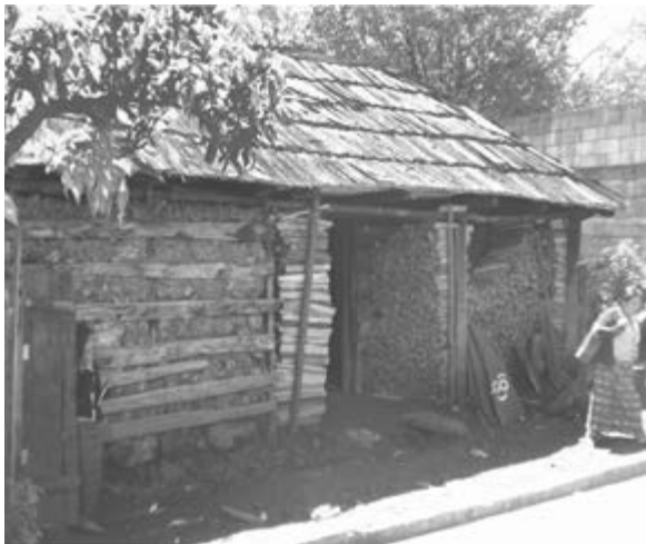
Figura 2. Casa tradicional de bajareque y tejamanil (zona de almacenamiento de leña), cabecera de San Mateo Ixtatán, 2008. (Fotografía: R. Piedrasanta).
