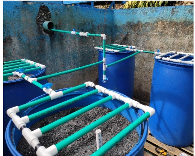
Figura 4. Pilotos MSL instalados.
